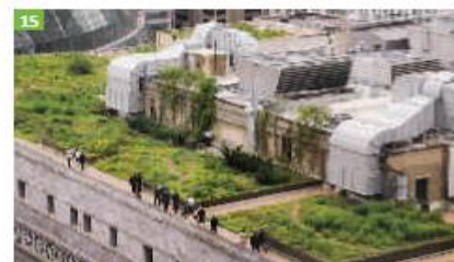
Green Roof, Ayuntamiento de Chicago
