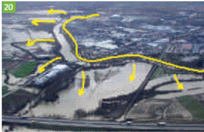
20 Laminación de avenidas del río Zadorra, Vitoria-Gasteiz
