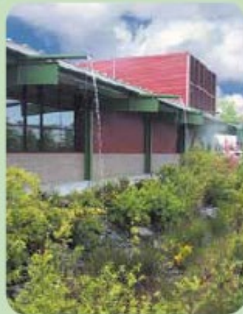
Sistemas de recogida de aguas pluviales. Portland.
