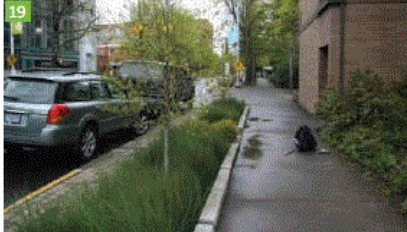
19 Retención y filtrado de aguas pluviales, Portland
