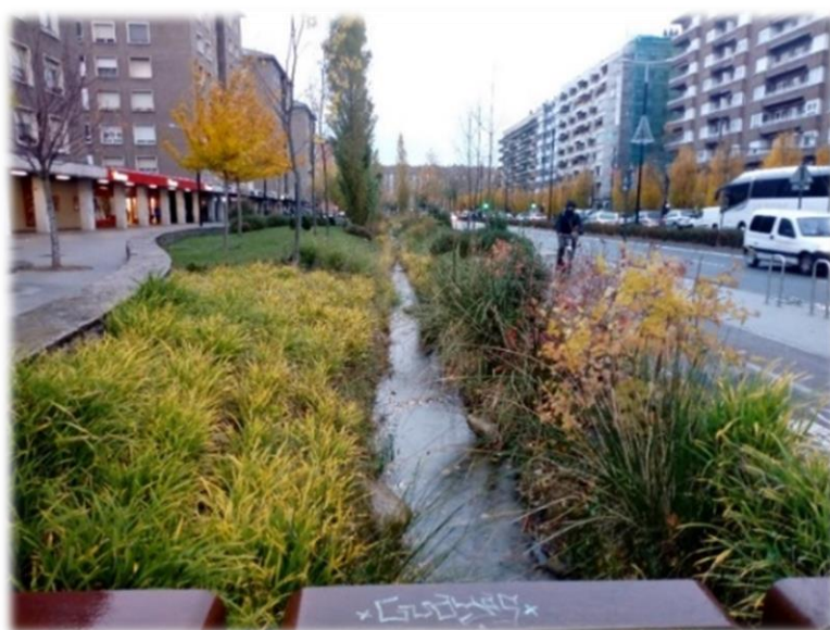
Estanque lineal en la avenida Gasteiz de Vitoria-Gasteiz (Araba)
