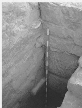
Foto 3. El Sequeral. Detalle del apoyo de uno de los tirantes en el lienzo de opus quadratum .
