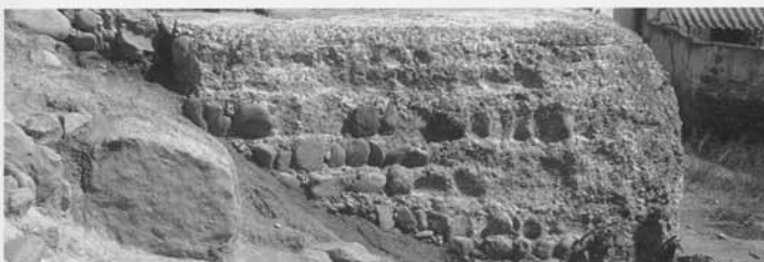
Foto 4. El Sequeral. Detalle de uno de los laterales del opus caementicium.
