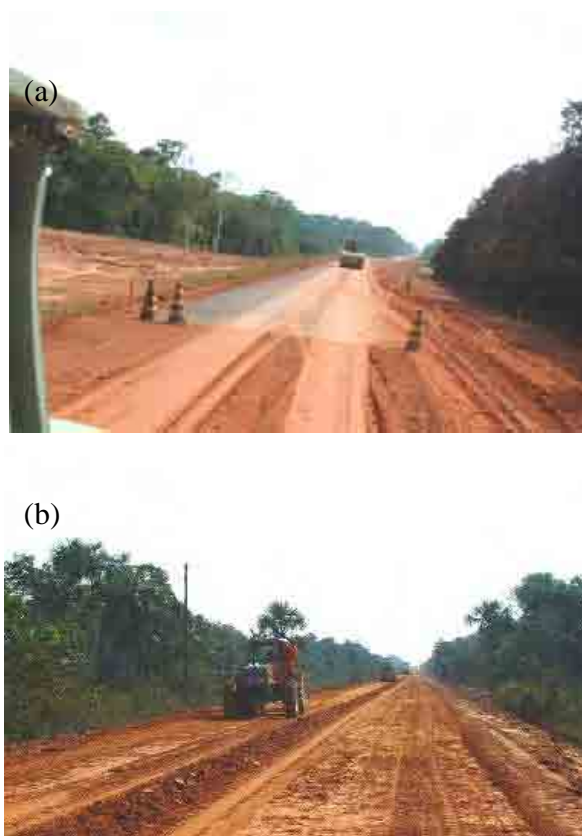
Fig. 9. Maquinaria vial trabajando en el primer tramo de la Ruta BR-319. En a) tramo entre Careiro Castanho e Igapó Açu, casi completamente asfaltado, en b) tramo Igapó Açu – Rio Tupana en consolidación.
