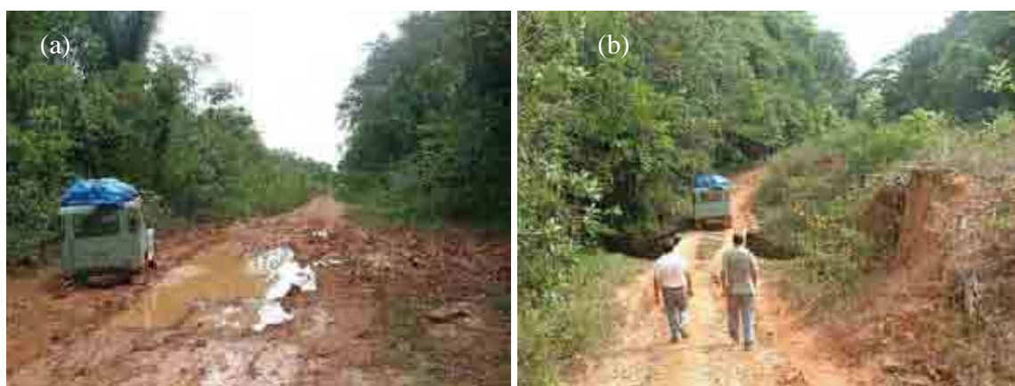
Figura 4. Estado actual del tramo medio de la Ruta BR-319. (a) Destrucción total de la carpeta asfáltica, y en (b) uno de los numerosos riachos que son cruzados en condiciones precarias.
