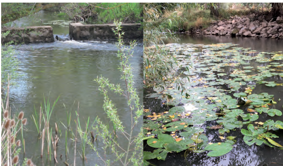
Figura 2. Aspecto del río (izq.) previo y; dcha.) posterior al derribo del azud.
