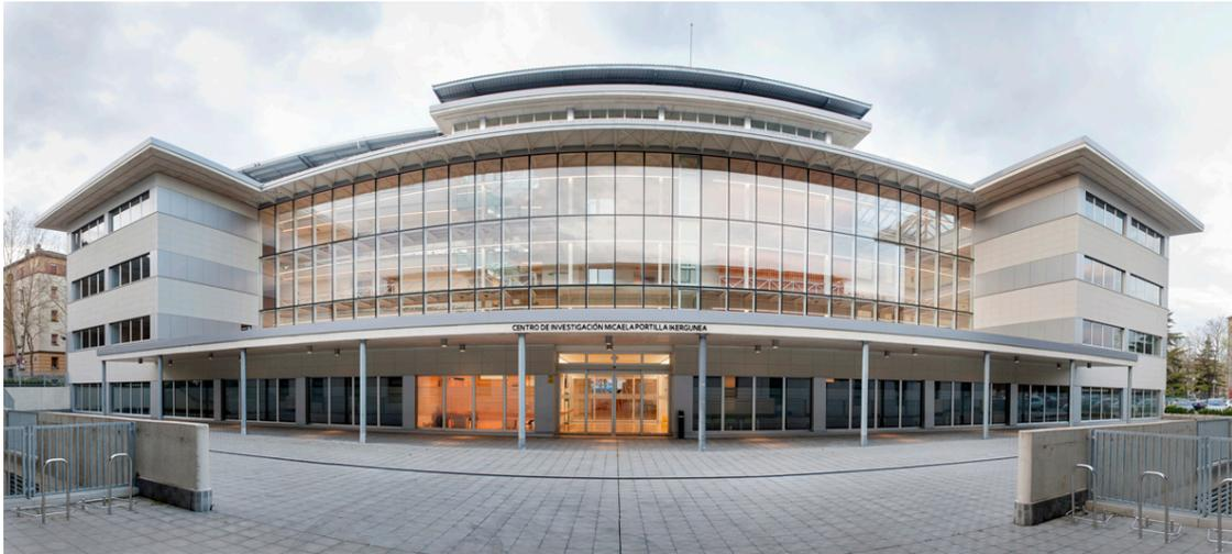
**El edificio cuenta con varios componentes singulares que lo sitúan en la vanguardia de la construcción dotacional. De ellos destaca el cierre estructural de toda la envolvente mediante panel contralaminado de madera CLT. En su diseño de edificio de energía cero, se cuenta con varios componentes bioclimáticos, en vistas al ahorro energético, habiéndose estudiado cuidadosamente tanto el comportamiento térmico como el acústico del edificio.**
