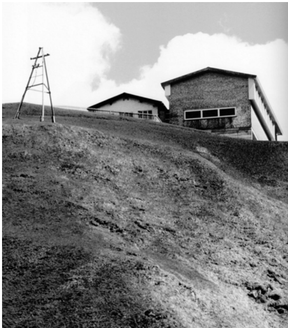
Gion Caminada (1995). Multipurpose Hall (Vrin, Suitza).
