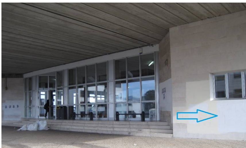
Distancias máximas entre los puestos de trabajo en la Secretaria Alumnado Leioa
