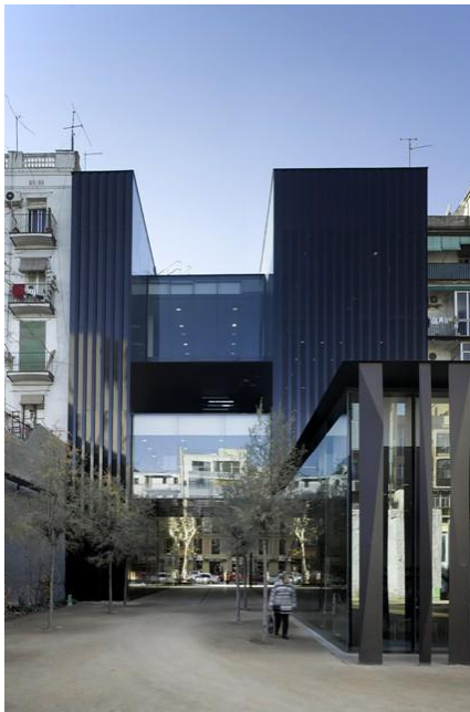
Biblioteca Sant Antoni – Joan Oliver, Barcelona, obra de RCR
