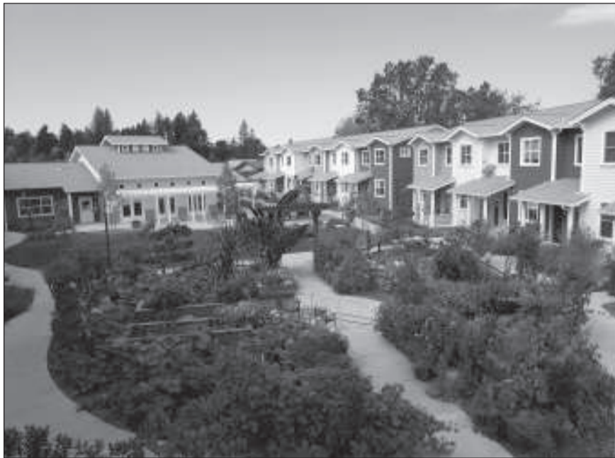
Foto cedida por la Cohousing Association of the US. Viviendas colaborativas en Petaluma, Cal., EE.UU.
