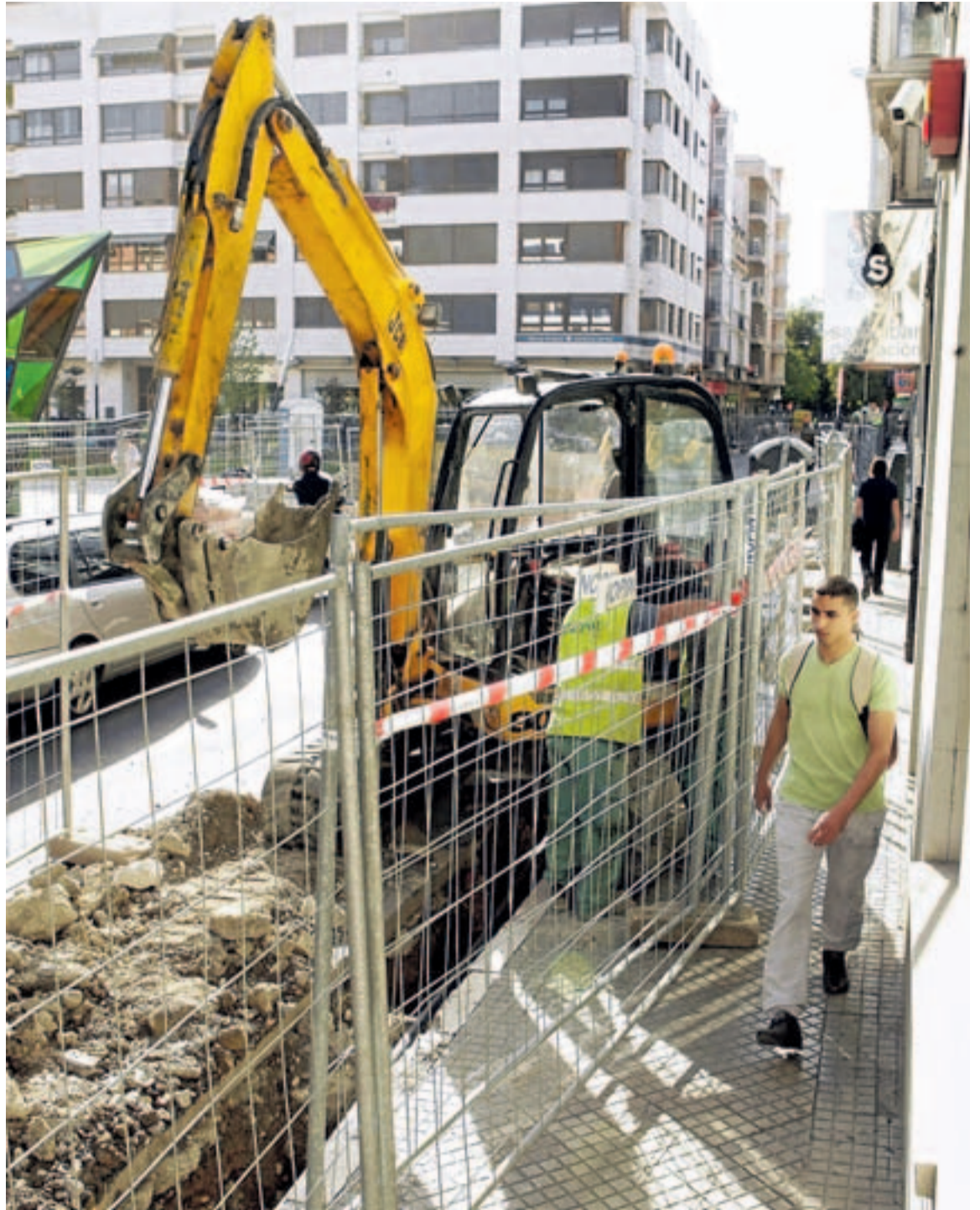
Los trabajos han causado molestias a conductores y peatones. :: RAFA GUTIÉRREZ
