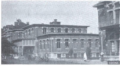
▲ Pabellón de cocinas. (Arch. Fot. Hospital de Basurto).
