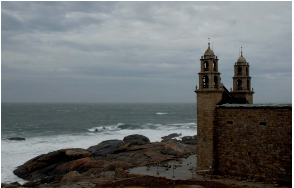
Imagen. Iglesia de Nosa Señora da Barca en Muxía, después del incendio, en un día de tormenta.
