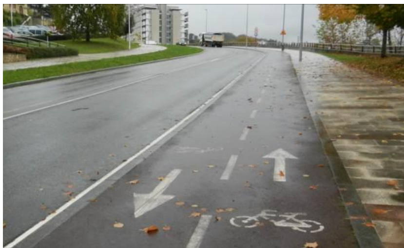
Foto 9. Acera-bici de la Avenida Elexalde (tramo segundo)
