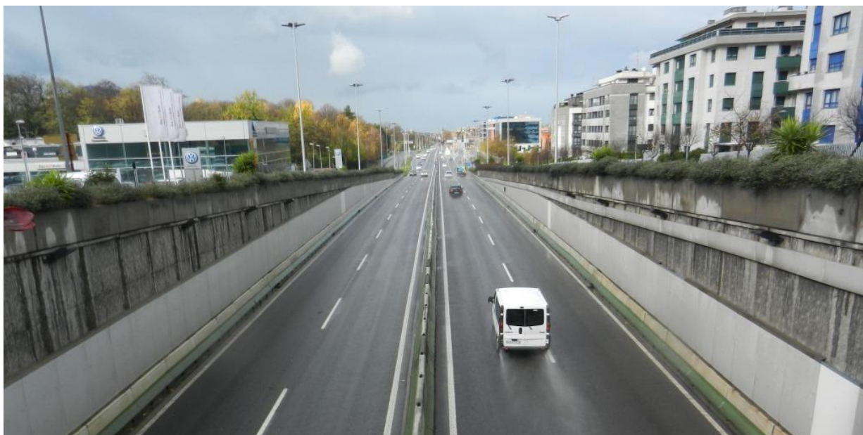
Foto 1. Aspecto de la BI-637 (autovía de la Avanzada) en su paso por el municipio de Leioa
