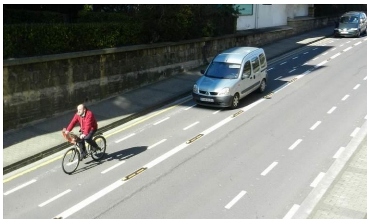
Foto 32. Ciclocarril en bajada y banda de protección en subida en Zarautz
