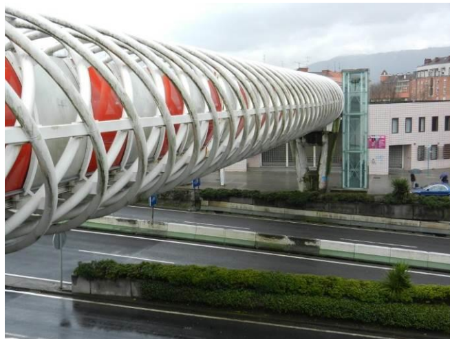
Foto 11. Paso elevado con ascensor en la Avenida Iparragirre
