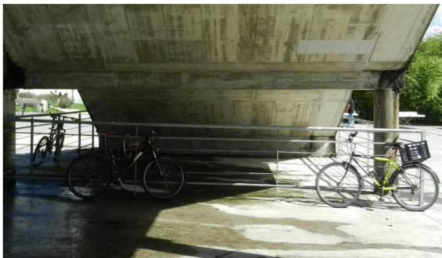
Foto 29. Barandillas convertidas en aparcabicis informales
