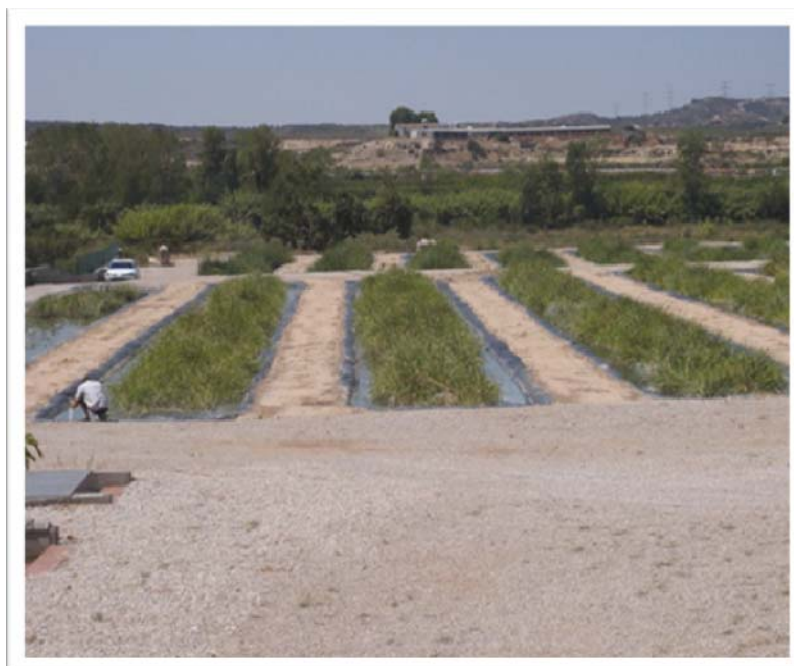
Figura 3.3 EDAR de Fabara
