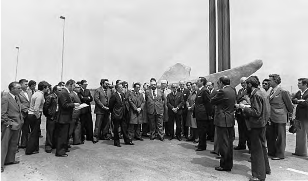
Inauguración por el Ministro de Obras Públicas de la Solución Sur (tramo Bilbao-Barakaldo) (8.06.1977).
