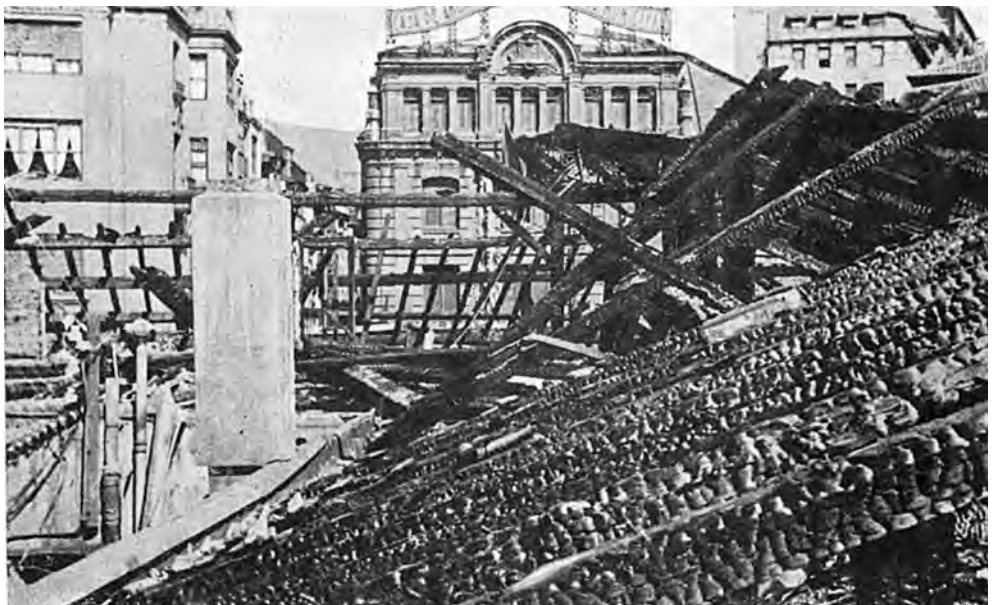
Techumbre de la Iglesia de San Antón tras el incendio (marzo de 1959).
