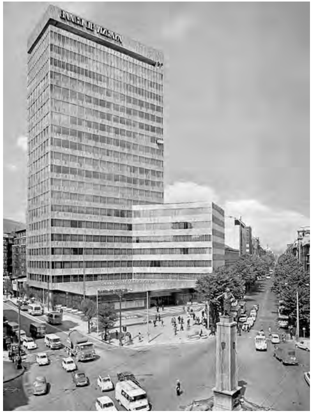
Edificio del Banco de Vizcaya, muestra del urbanismo incontrolado.
