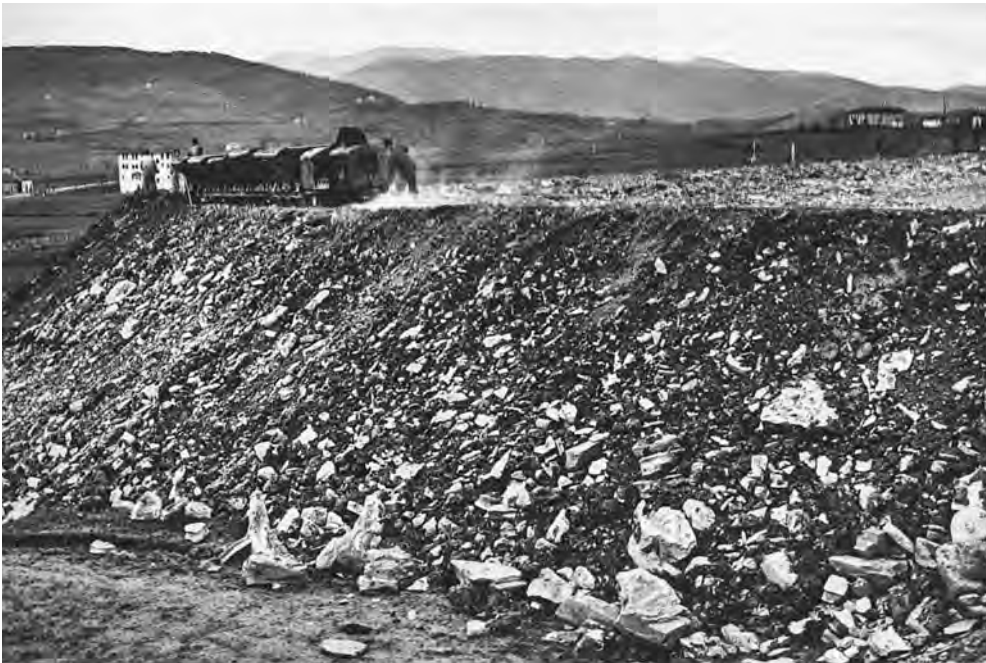
Obras del aeropuerto de Sondika con represaliados políticos en los años cuarenta.
