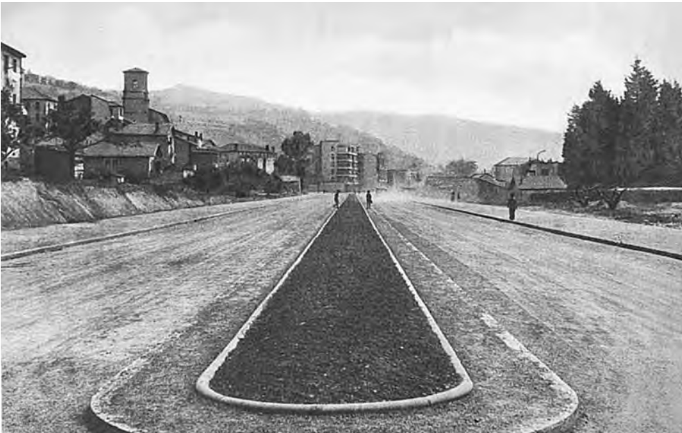
Obras de la Avenida del Ejército.
