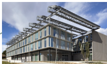
Cerdanyola del Valles. Electromechanical Systems
