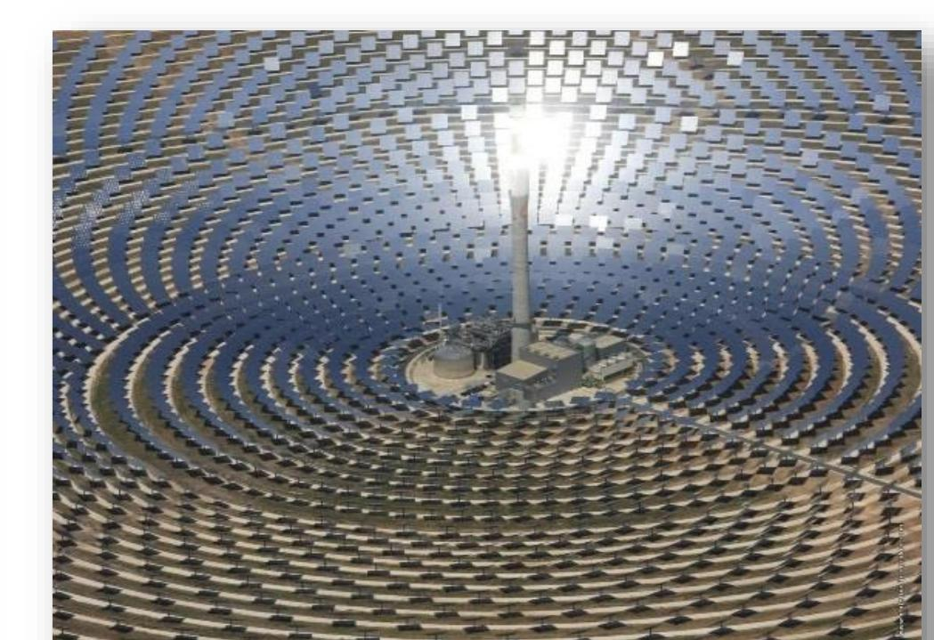
En la naturaleza el girasol distribuye y coloca sus semillas de tal forma que **aprovecha al máximo el espacio** disponible en su superficie. Este principio se ha aprovechado en el mundo de la ingeniería para posicionar los heliostatos de una central termosolar para proporcionar una **mayor producción de energía en un menor espacio**. Gracias a ello se consigue una **mayor eficiencia**.
