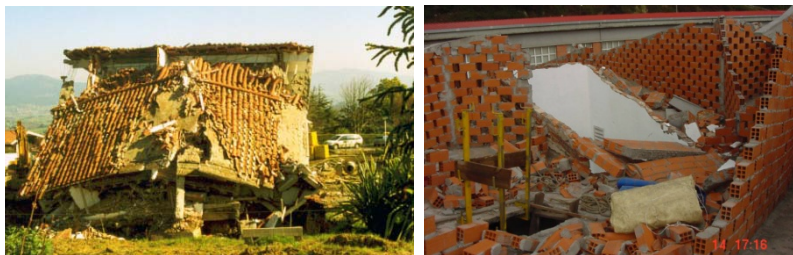
Figura 1. Ejemplo de daños presentes en la edificación
