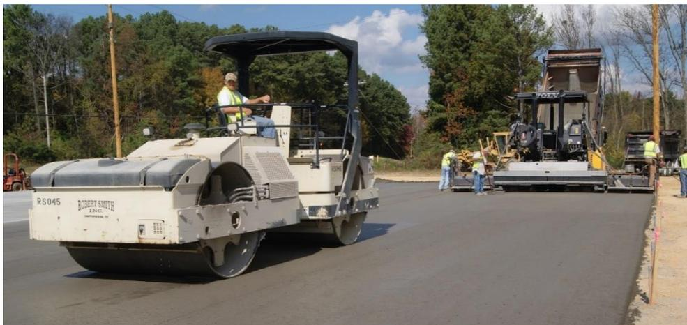
Figura 10. Puesta en obra de pavimentos de HCR [21].
