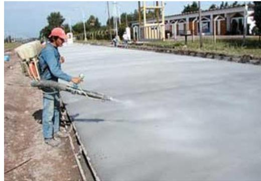
Figura 8. Compactación (izda.) y extendido emulsión curado (dcha.) del HCR [21].
