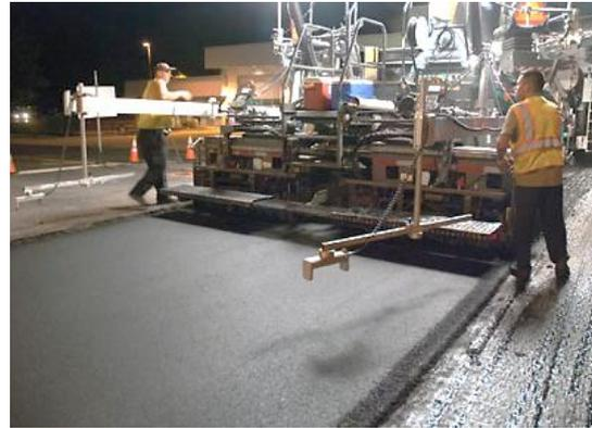
Figura 7. Colocación (izda.) y extendido (dcha.) del HCR [21].
