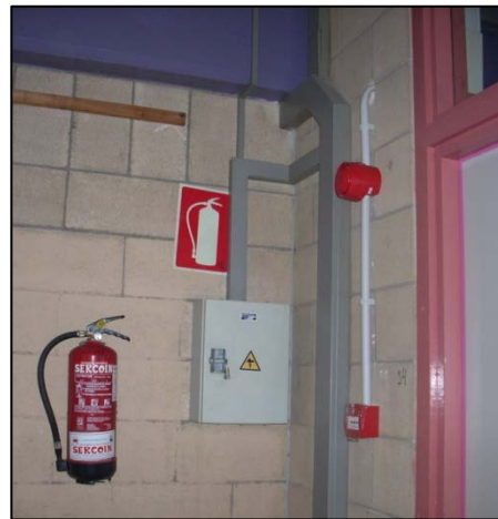
Pulsador de alarma sin señalizar
