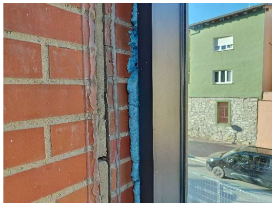
Figura 36. Relleno y aislamiento de marcos de ventanas con espuma de poliuretano.
