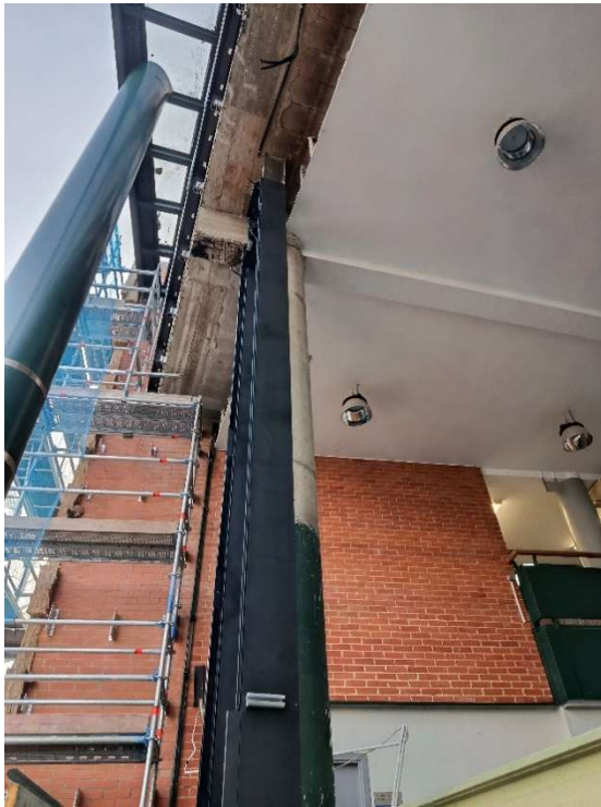
Figura 45. Ejecución del muro cortina en la entrada principal
