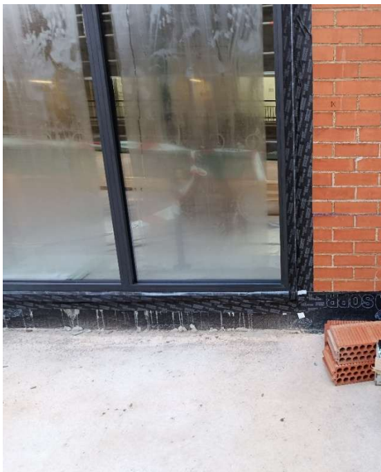
Figura 47. Impermeabilización de recercos con lámina de polietileno.
