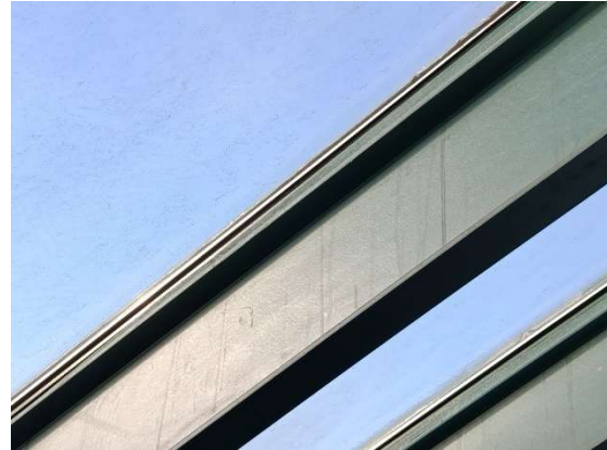
Figura 50. Estructura actual del lucernario del interior.
