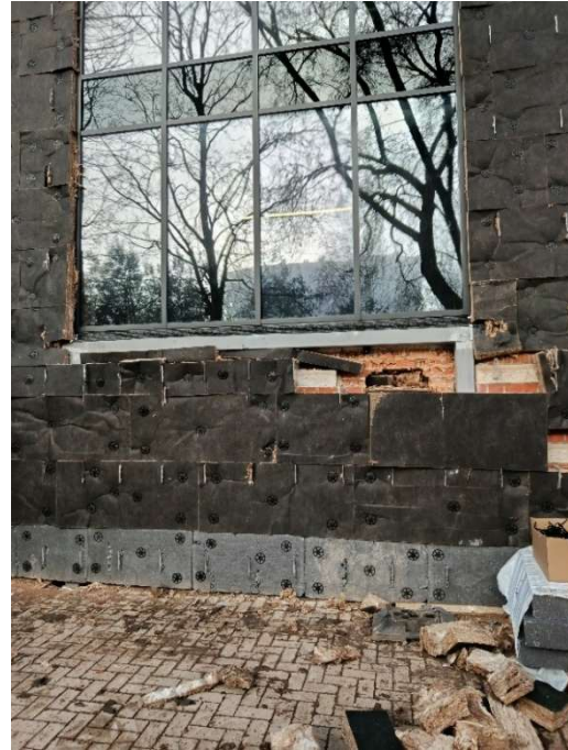
Figura 42. Ejecución de la fachada ventilada.
