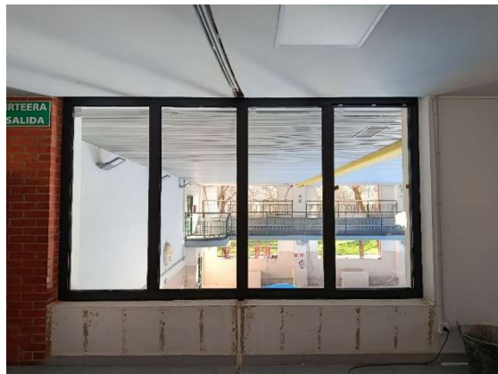
Figura 34. Carpintería interior con resistencia al fuego.
