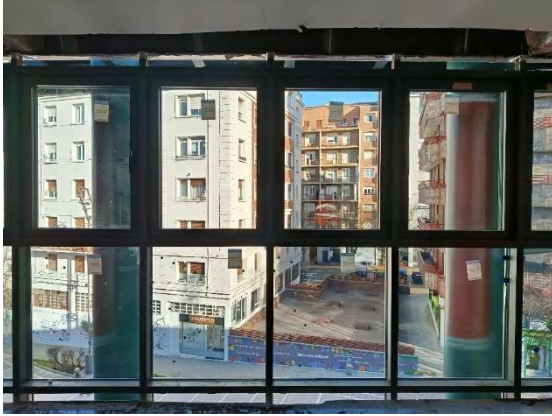
Figura 27. Muro cortina de la fachada principal visto desde el interior (parte de la estructura y vidrios instalados).
