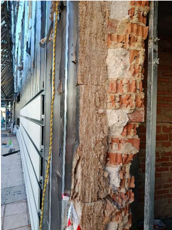
Figura 39. Muro de fijación del sistema de fachada ventilada.
