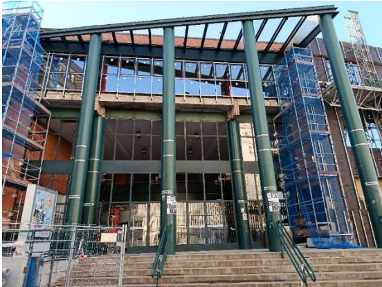
Figura 37. Montantes anteriores de la entrada principal
