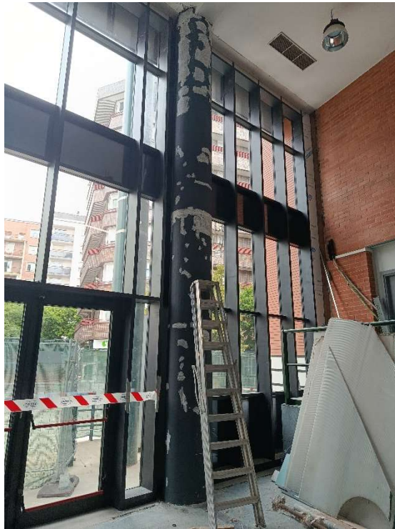
Figura 54. Muro cortina de la puerta principal desde el interior ejecutado.
