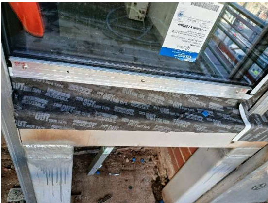
Figura 33. Impermeabilización recercos de carpintería con lámina de polietileno.
