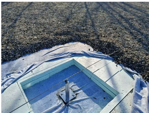
Figura 13. Detalle de la ejecución de la cubierta plana invertida no transitable, se aprecian las diferentes capas que la componen junto con el anclaje de la línea de vida.
