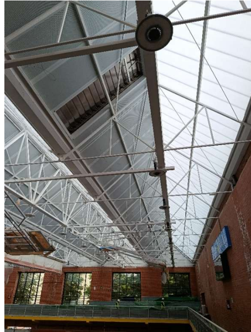
Figura 52. Cubierta ligera desde el polideportivo terminada.
