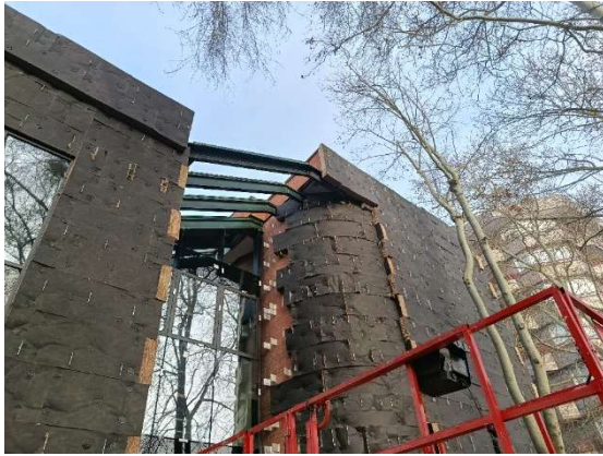
Figura 41. Ejecución de la fachada ventilada.
