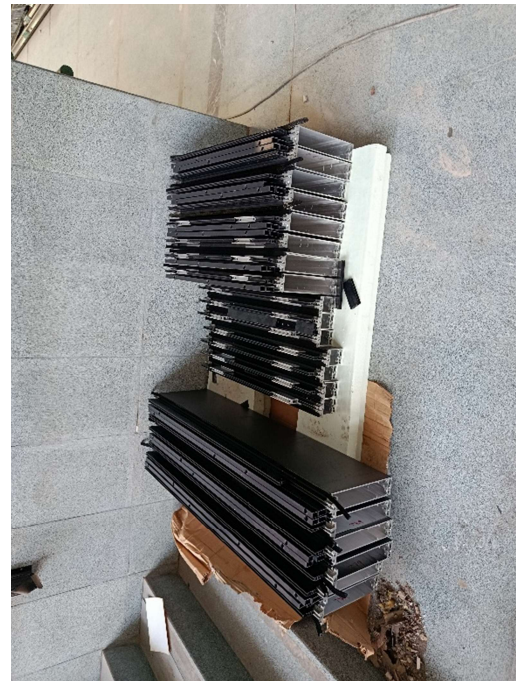
Figura 44. Montantes verticales y horizontales del muro cortina.
