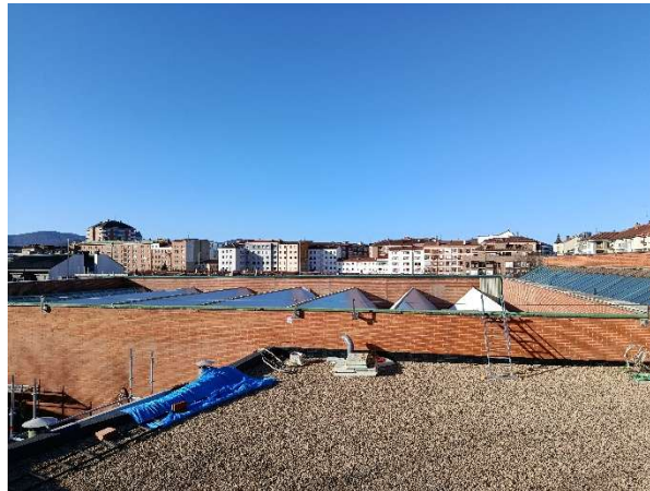
Figura 14. Cubierta inclinada vista desde arriba, junto con la cubierta no transitable de grava (fotografía tomada durante la visita de obra)
