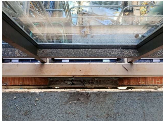
Figura 32. Perfil de refuerzo del muro cortina.
