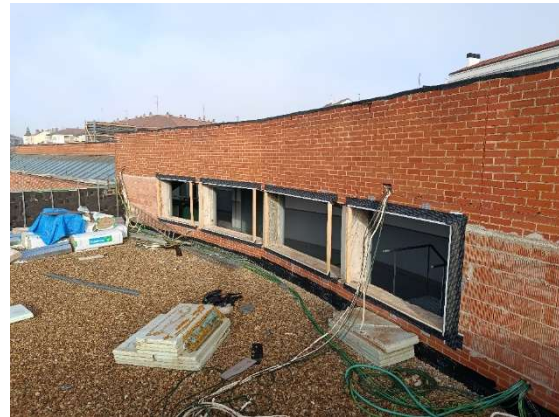
Figura 46. Premarcos impermeabilizados.
