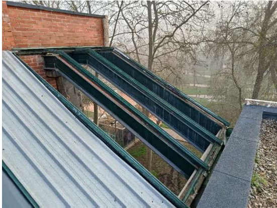
Figura 49. Estructura actual del lucernario exterior.
