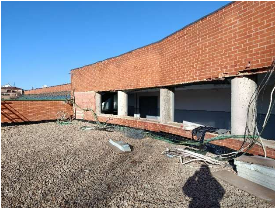
Figura 31. Huecos de las nuevas carpinterías a instalar.
