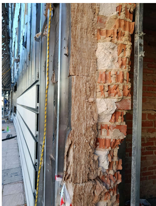
Figura 16 y Figura 17.: Detalle de la ejecución de la fachada ventilada, donde se aprecian la fábrica existente, el aislamiento térmico de lana mineral, la subestructura metálica y el revestimiento exterior de hormigón polimérico (Alberola, 2025).
