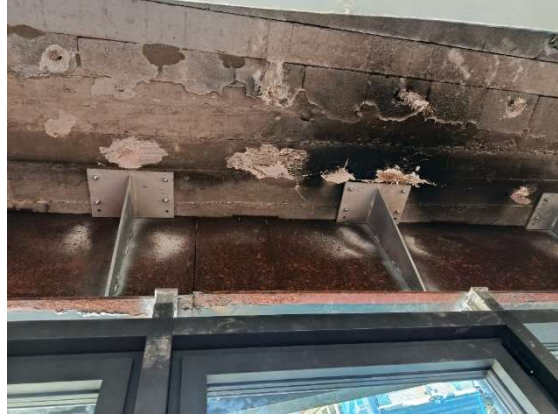
Figura 28. Refuerzos sujeción del dintel al forjado.
