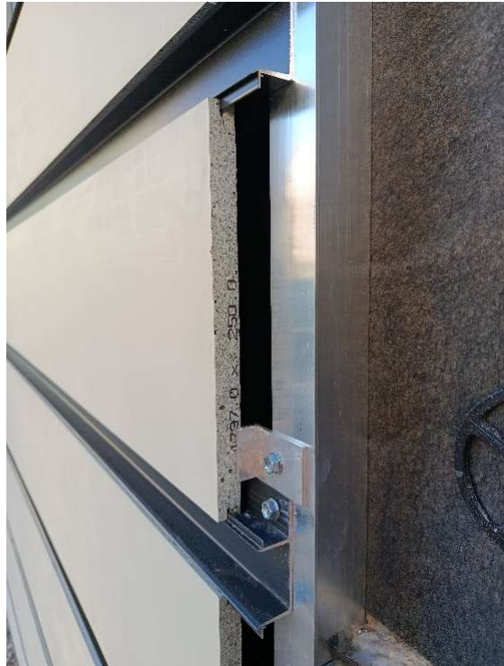
Figura 40. Placa de hormigón polimérico sobre perfil guía intermedio.
