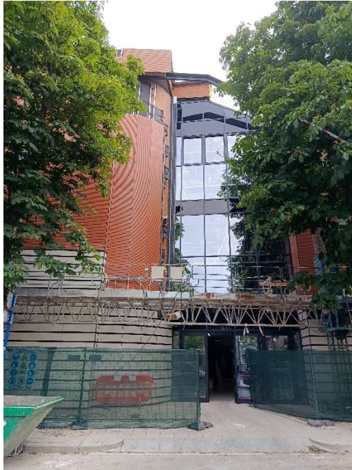
Figura 51. Muro cortina y fachada ventilada de la calle Aramburu en ejecución.
