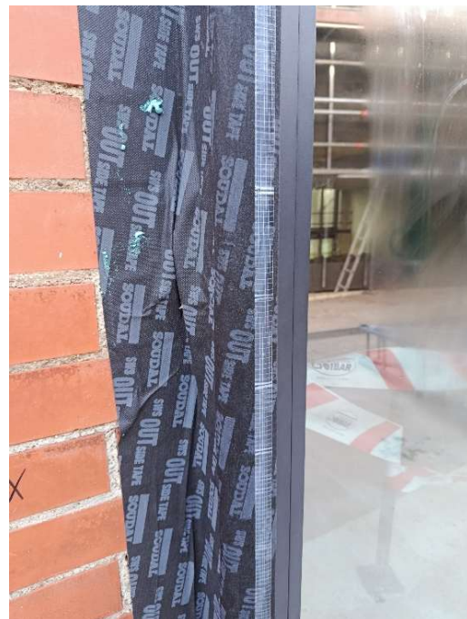
Figura 48. Impermeabilización recercos con lámina de polietileno.
