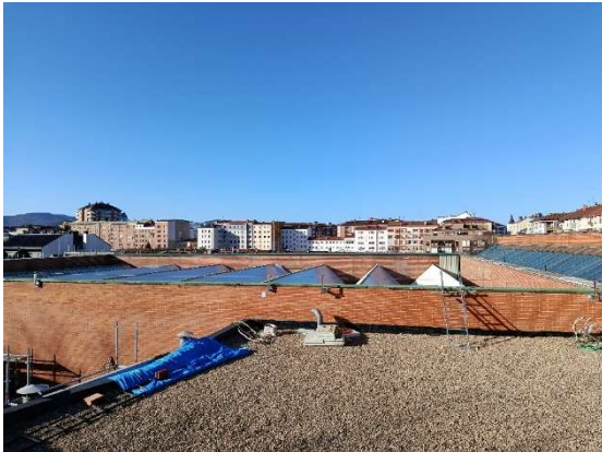
Figura 29. Cubierta no transitable de grava, junto con la cubierta inclinada vista desde arriba (instalación en curso del policarbonato).
