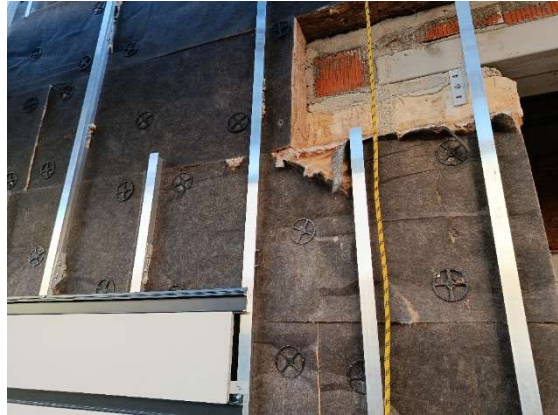
Figura 38. Subestructura vertical de aluminio.
