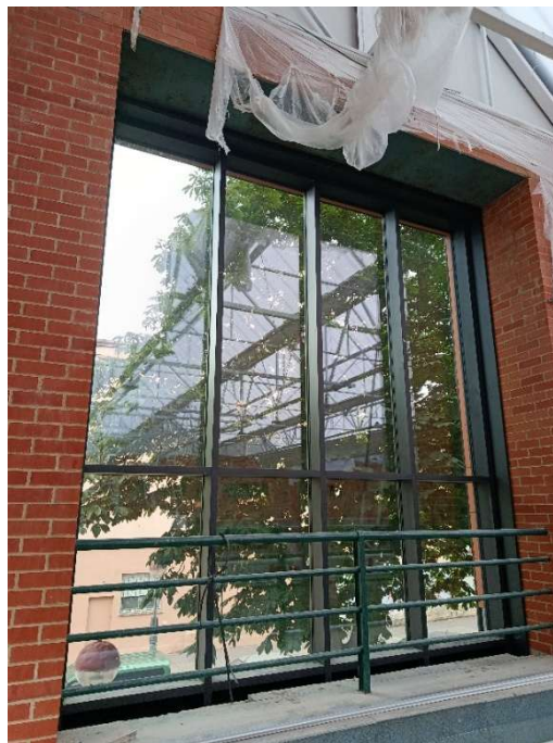
Figura 53. Muro cortina visto desde el interior del polideportivo.
