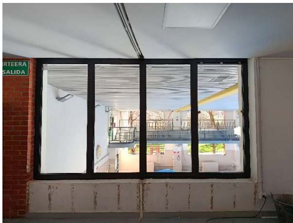
Figura 10. Ventana interior RF (fotografía tomada durante la visita de obra).
