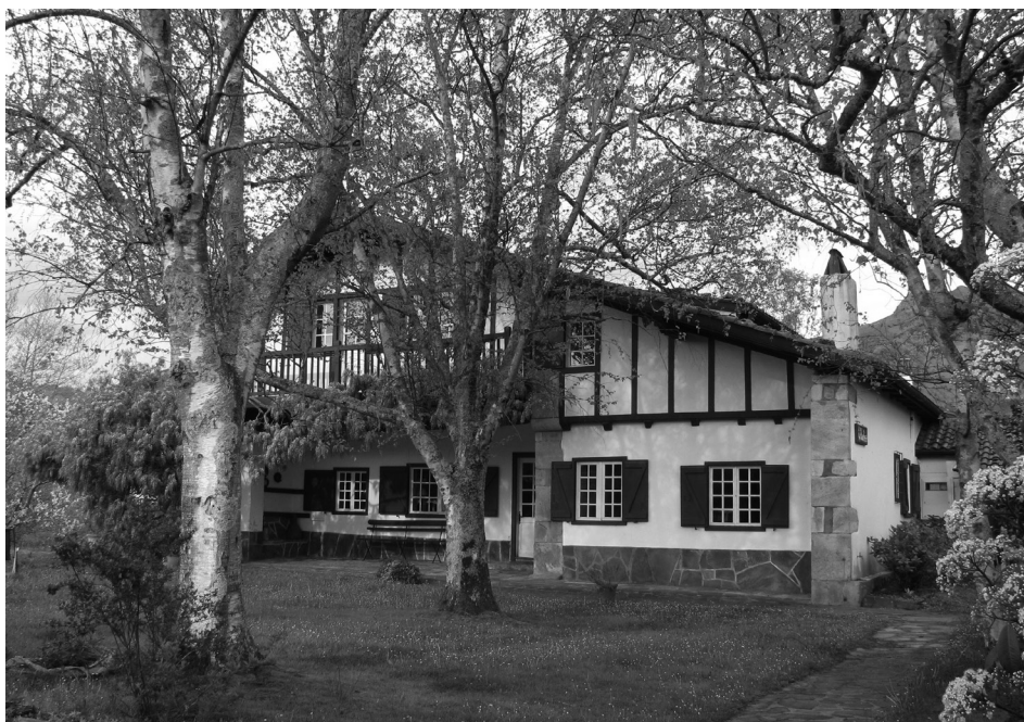
Figura 3. La casa Bidartia en su estado actual.
