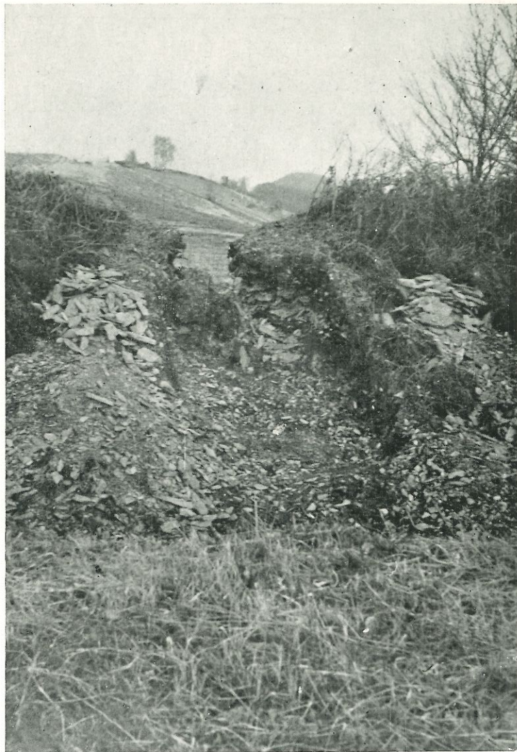
Fot. 13.—Terraplén D: zanja abierta en el n.º 10 (Fig. 13), durante la segunda campaña.
