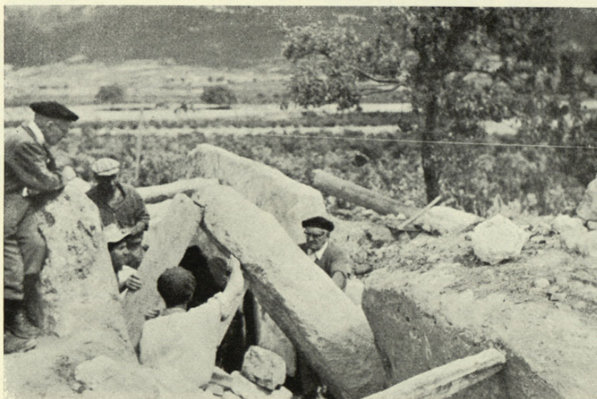
Fot. 4.—Levantamiento de las losas caídas en la cámara.
