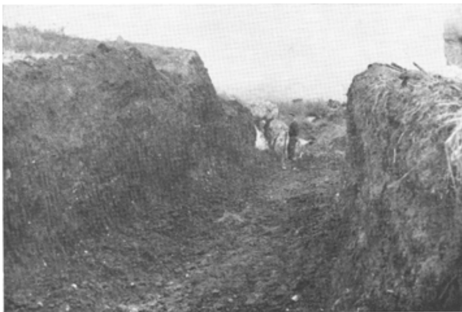
Foto 4.-Abriendo la trinchera NW-SE., en Aizkomendi (Foto A. Llanos).
