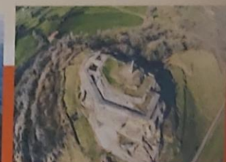
Aizoa, gotorleku (16. mendea). Nafarroa eta Gazteltan arteko mugak. Gortia de Aizoa (Gipuzkoa, Espainia). Siglo XVI. En la frontera entre Castilla y Navarra.
